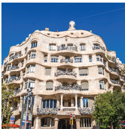
La Pedrera, Barcelona
